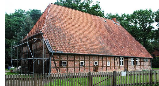
Sanierung Zweistöcker-Fachwerkhäuser in Krelingen bei Walsrode
