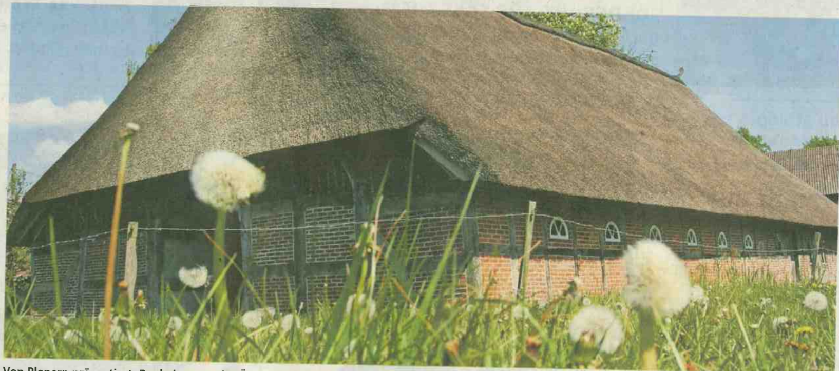
Von Planern präsentiert: Baukultur aus der Ära von „Eckes Hus“ in Ostereistedt bis zu Gebäuden, die in der Nachkriegszeit entstanden sind. Foto Hilken
