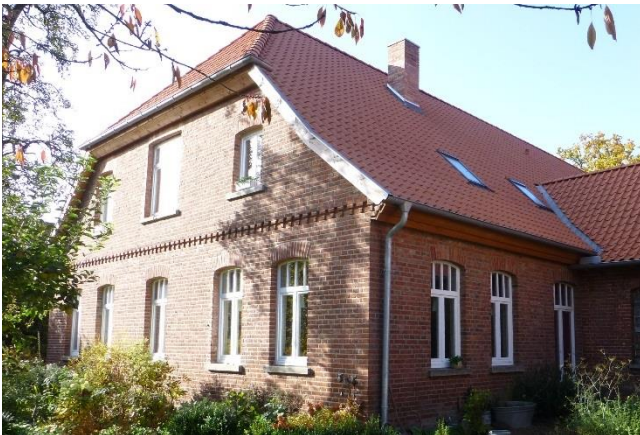
Umfassend saniertes Gebäude – Dach, Fenster, Steinverfugung
