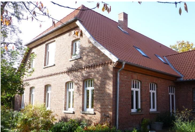
Umfassend saniertes Gebäude – Dach, Fenster, Steinverfugung
